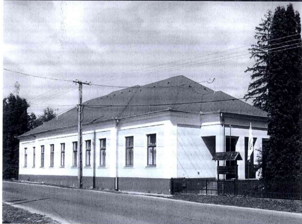
Hagyományos épülettömeg hagyománykövető anyaghasználatú felújítása, léptéktartó bővítése
