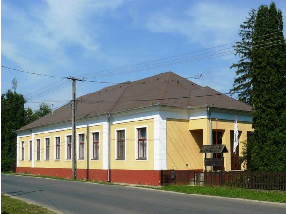
Hagyományos épülettömeg hagyománykövető anyaghasználatú felújítása, léptéktartó bővítése
